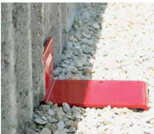
Z-profil 485/50 mechanismus proti posuvu je zatlučen do štěrkového lože a přisazen k betonovému prvku
