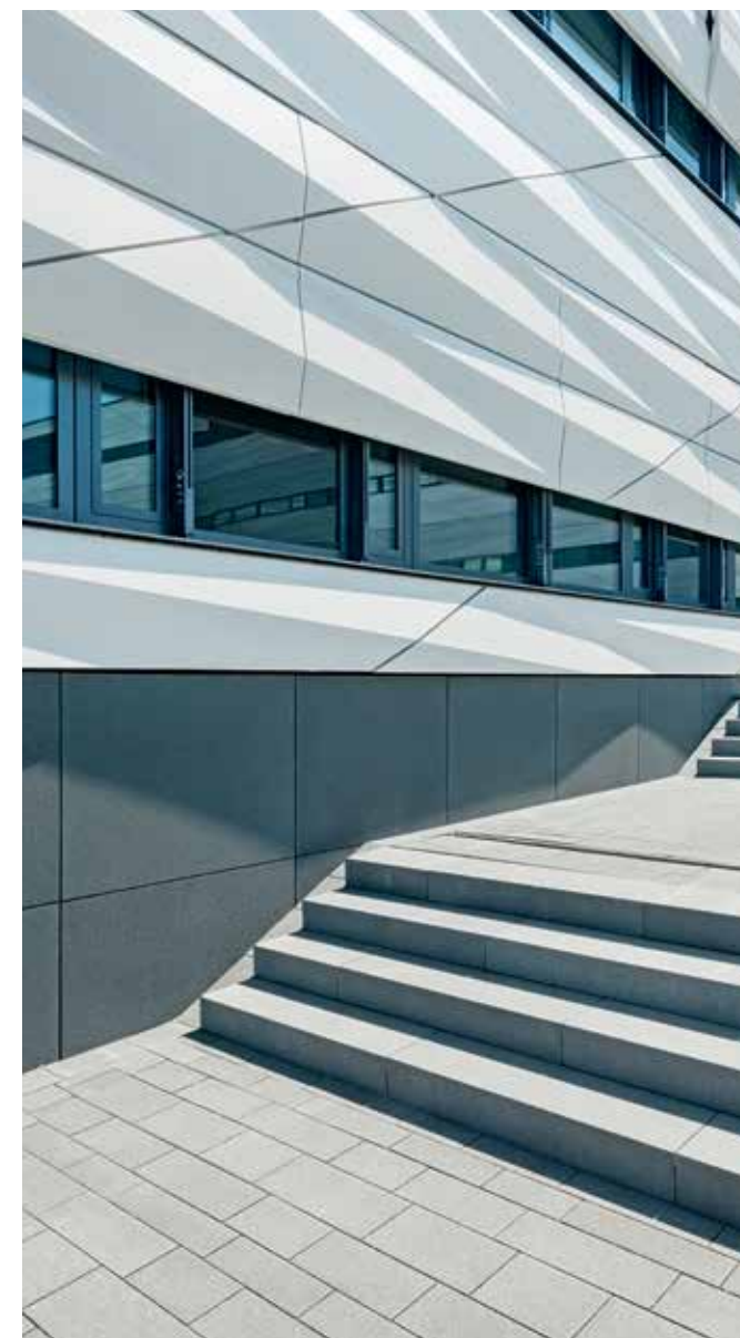
GDM.SCADA kombiforma – typ AD se schody
