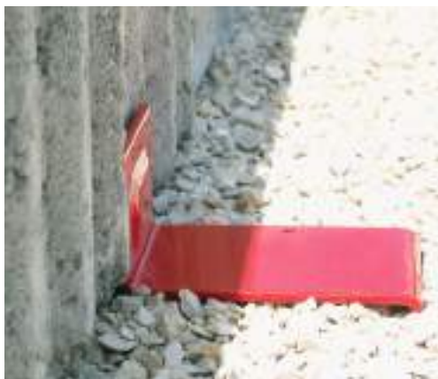
Z-profil 485/50 mechanismus proti posunu je zatlučen do štěrkového lože a přisazen k betonovému prvku
