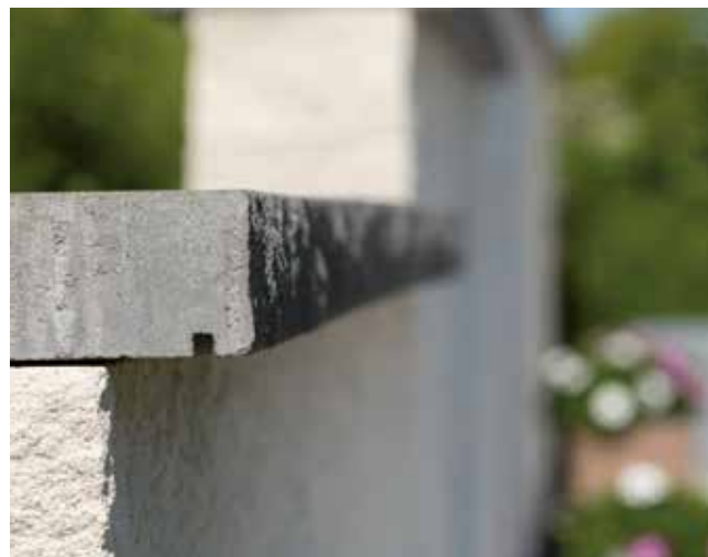
NOVOLINE® linear DTE100 krycí k. s okapničkou po obou str. podél antracit 50/36/7,5 cm
